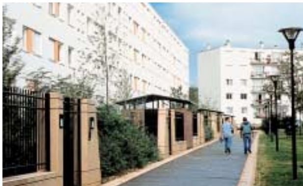
Cité « Les Merisiers » à Aulnay-sous-Bois, Logement Français, maître d'ouvrage.
