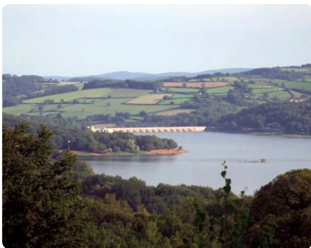
LAC-RÉSERVOIR DE PANNECIÈRE-CHAUMARD Photo : Benchaum
