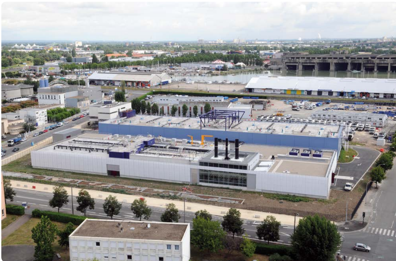
LA STATION D'ÉPURATION LOUIS FARGUE (JUILLET 2012)
