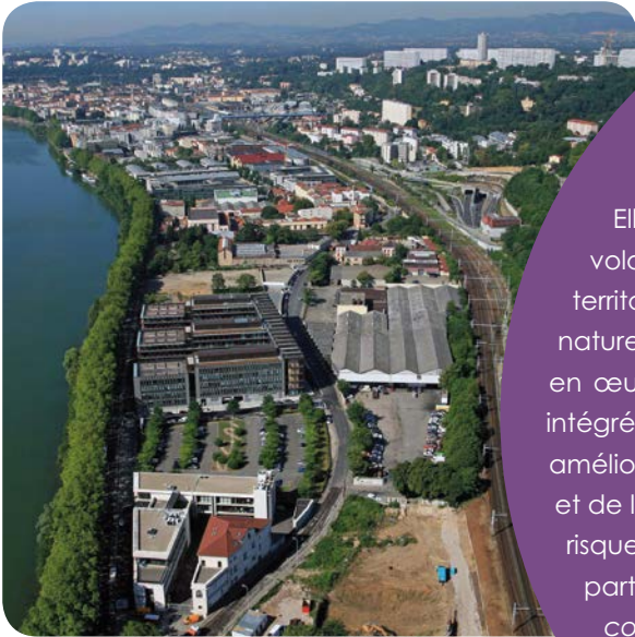
LE COULOIR DE LA CHIMIE, FEYZIN Photo : SERL, Balloïde, H. Canet
