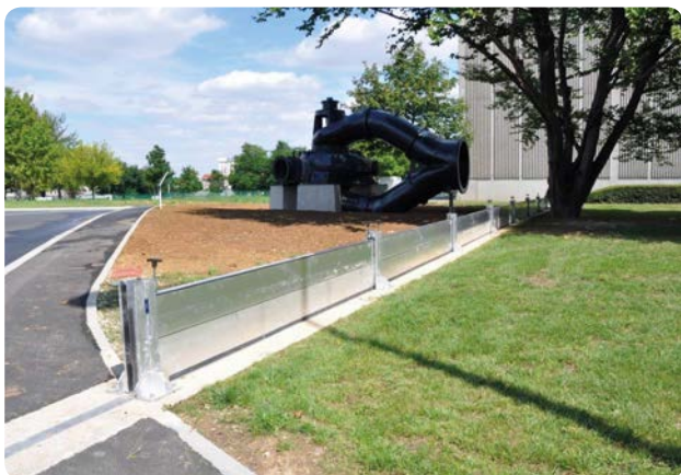
BARRIÈRES AMOVIBLES ANTI-CRUES DE L'USINE SEDIF DE CHOISY-LE-ROI
