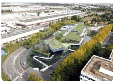
SEINE MORÉE : UNE USINE COMPACTE EN MILIEU URBAIN
