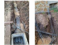
Travaux de tranchée pour pose des fourreaux PVC
