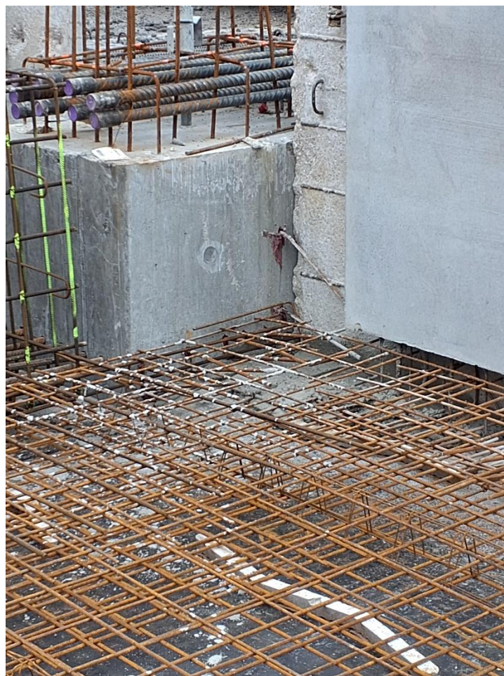
Figure 10 : ferrailage de la dalle, plancher haut du R+1
