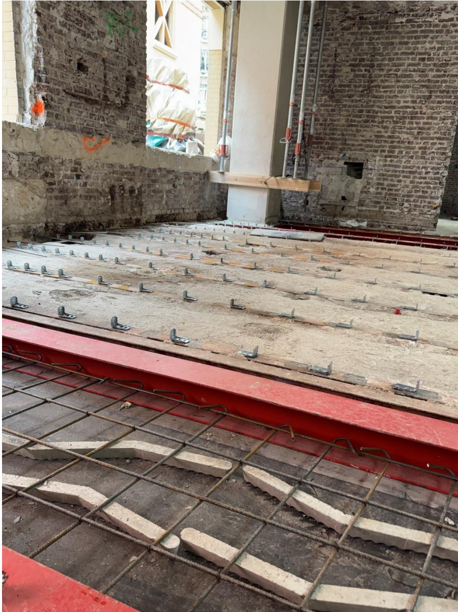
Figure 18 : pose des connecteurs Laterlite
