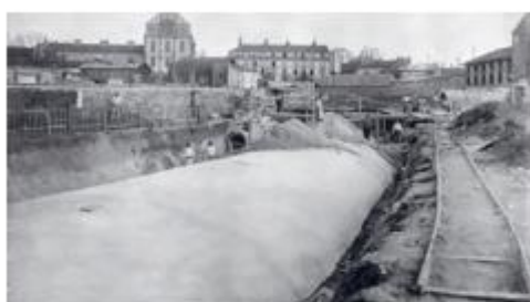
1910. Construction de la ligne A du Nord-Sud - 1 er lot - rue Desnouettes, raccordement avec le dépôt et les stations, la voûte du souterrain est complètement terminée et les 2 égouts latéraux sont en construction à proximité de l'actuelle rue Auguste Chabrières.
