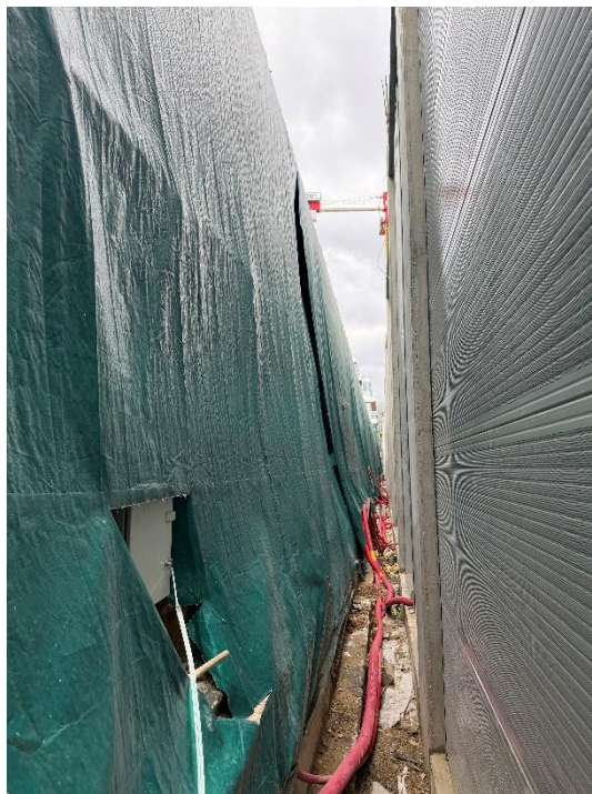
Figure 15 : séparation provisoire en laine de roche entre zone en travaux et zone en exploitation
