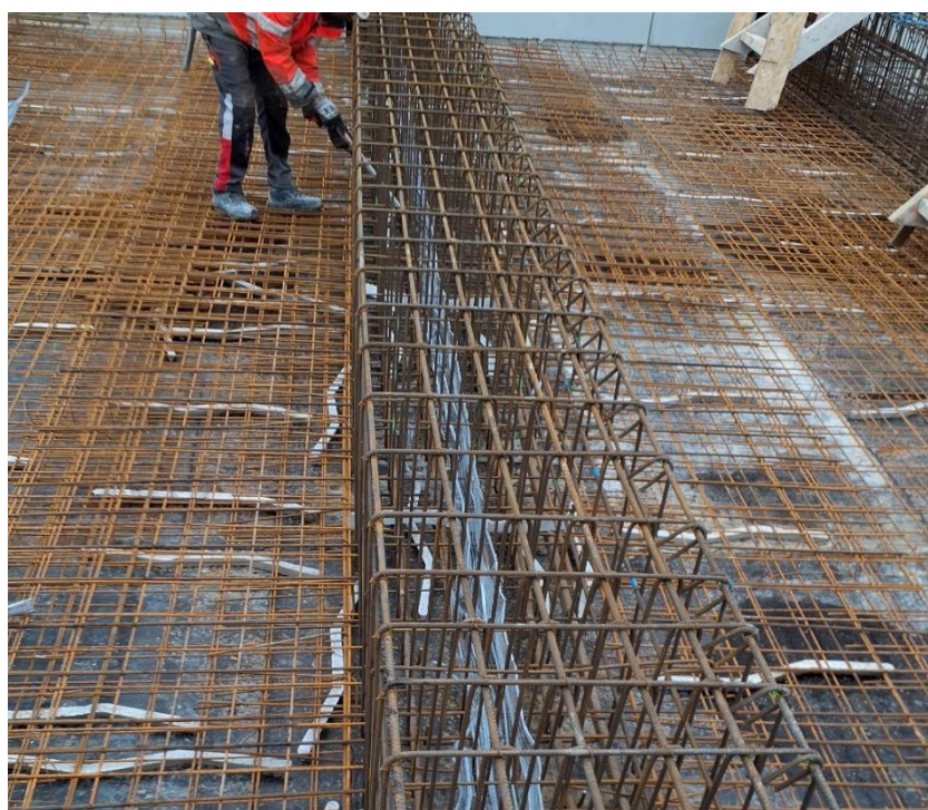
Figure 4 : contrôle du ferrailage du plancher haut du R+1 et des poutres supportant les sheds
