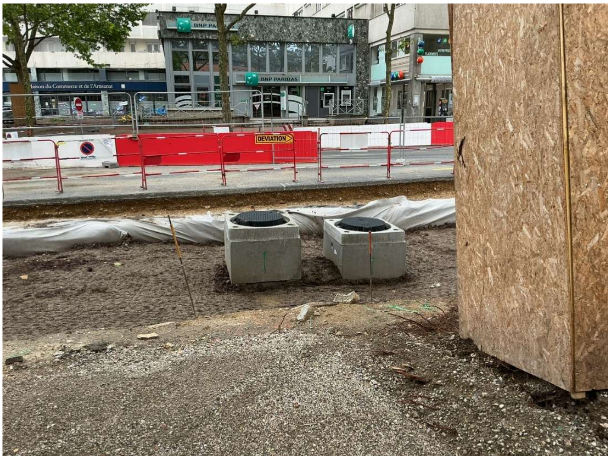
Figure 6 : Réalisation finie de la pose des 2 regards de surverse
