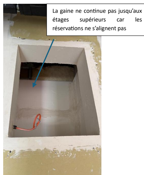
Figure 28 : Solution établie pour la gaine STAFF
