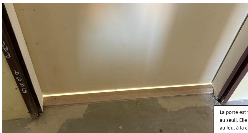
Figure 32 : Sur-élévation de la porte par rapport au seuil (Source : production personnelle)
