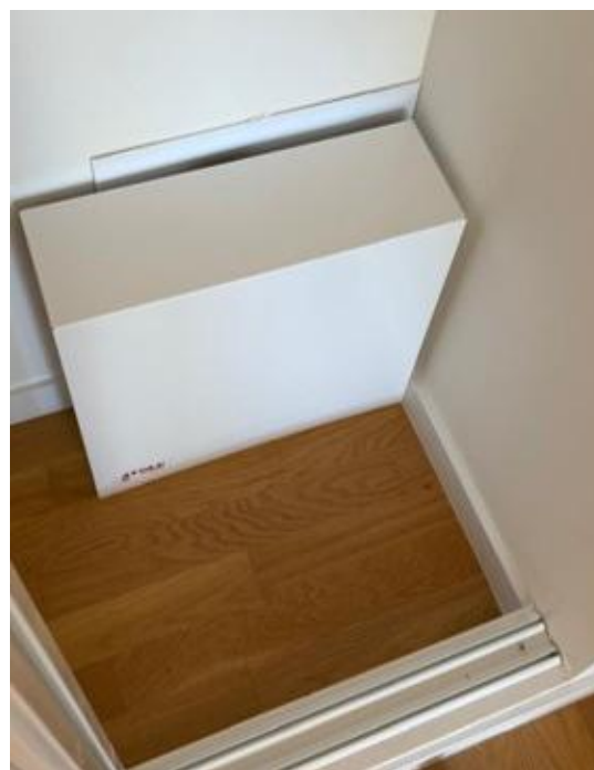
Figure 35 : Cache nourrice non-conforme (Source : production personnelle)
