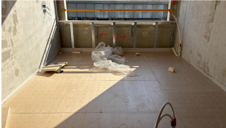
Figure 24 : Ossature du doublage et arrêt de chape sur la chambre témoin (Source : production personnelle)
