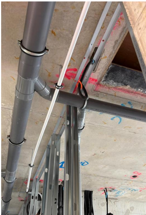
Figure 25 : Interfaces entre plomberie et plâtrerie au niveau du plafond (Source : production personnelle)
