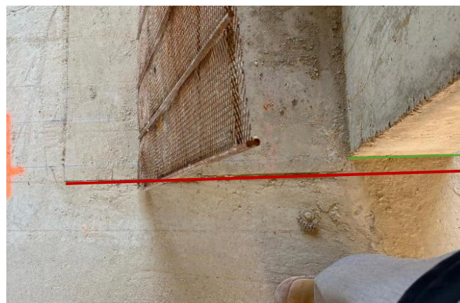
Figure 26 : Problème d'exécution concernant l'implantation de la gaine STAFF.
