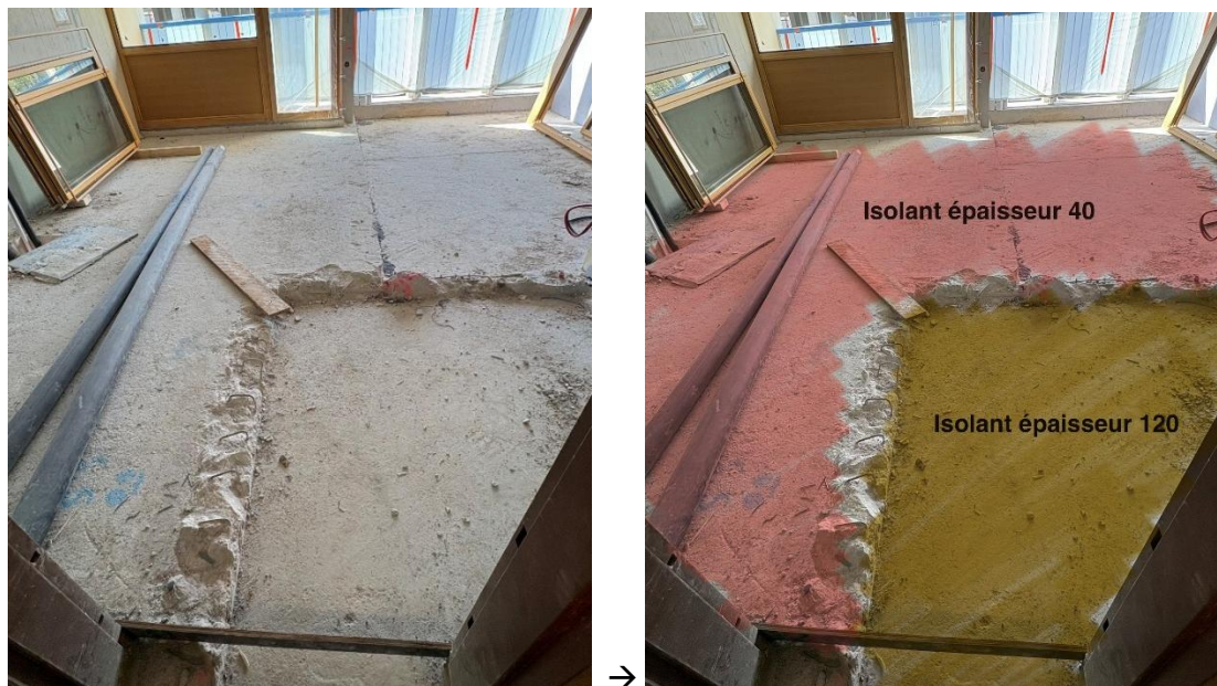
Figure 13 : Différence de niveau de dalle (Source : production personnelle)
