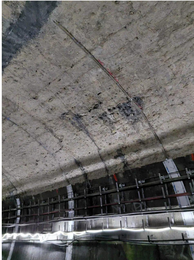
Figure 16 : Saignées drainantes réalisées tous les trois mètres, équipées de cordes captant les venues d'eau. Source : photo A. Dujardin, stagiaire de 3e année à l'ESTP, juillet 2026.
