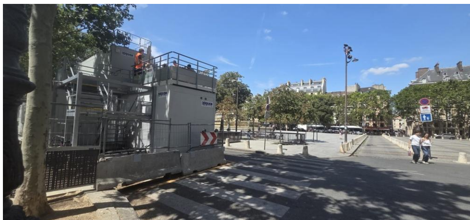
Figure 19 : Base vie du chantier installée en surface, sur l'espace public au droit de la station. Source : photo personnelle, A. Bouselma, 22 juillet 2026.
