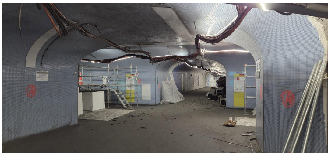
Figure 12 : Couloir de correspondance neutralisé avant travaux : dépose des équipements et des cheminements de câbles (source : photo personnelle, A. Bouselma, 1er avril 2026).
