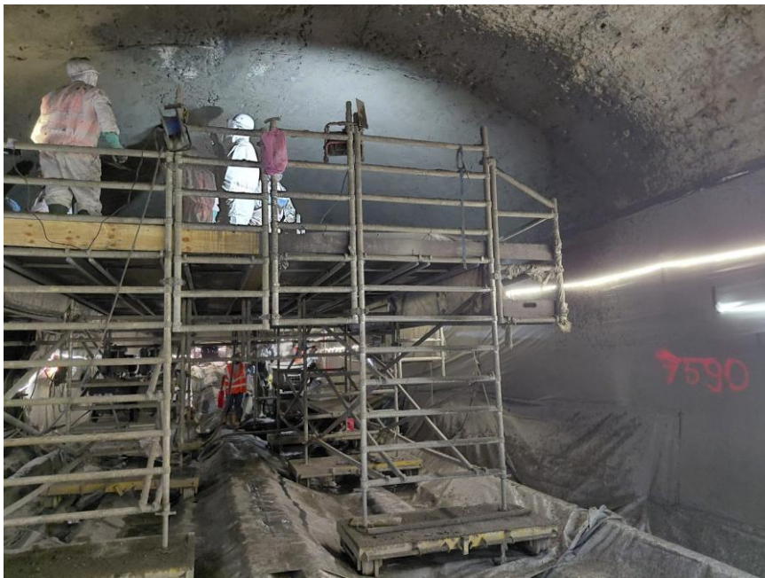
Figure 17 : Projection de l'enduit d'étanchéité depuis un échafaudage roulant, opérateurs sous protection intégrale. Source : photo A. Dujardin, stagiaire de 3e année à l'ESTP, juillet 2026.
