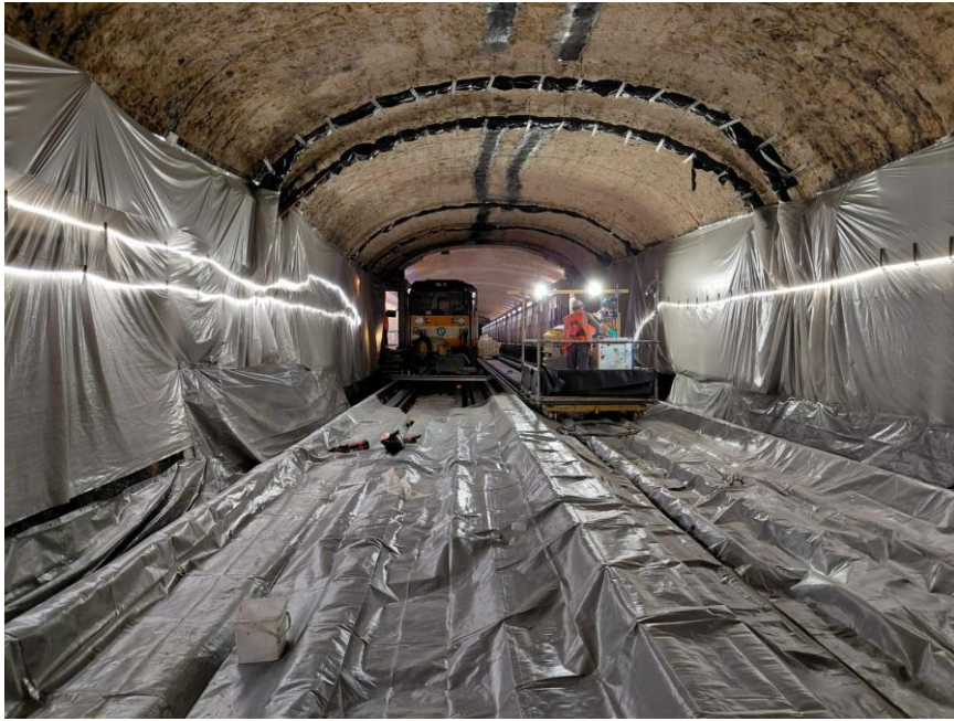
Figure 15 : Zone de travaux sous bâchage intégral, train travaux (locotracteur TMA) en approvisionnement — station Saint-Placide, ligne 4. Source : photo A. Dujardin, stagiaire de 3e année à l'ESTP, juillet 2026.
