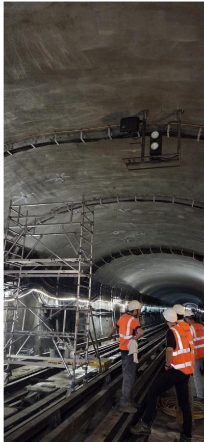
Figure 18 : Fin de chantier le long du quai de Saint-Placide : voûte enduite, bâches retirées et plateforme en cours de repli. Source : photo personnelle, A. Bouselma, 22 juillet 2026.
