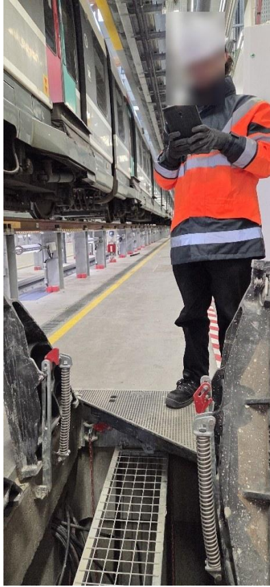
Figure 9 : Relevé de réserves sur tablette via l'application BulldozAIR, lors d'une visite dans le hall B (source : photo personnelle, A. Bouselma, AMT Massy-Palaiseau, 2026 ; visage anonymisé).
