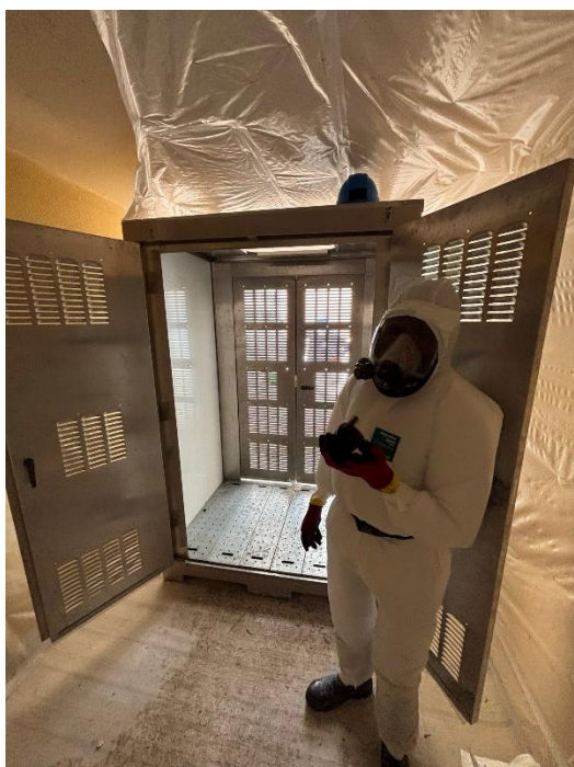
Figure 13 : Photo en zone « contaminée » du sas matériel
