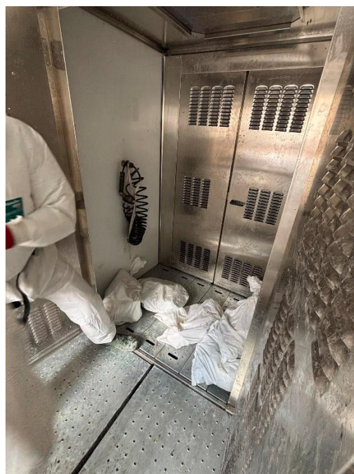
Figure 14: Photo de sacs à gravats en cours de décontamination dans le sas matériel
