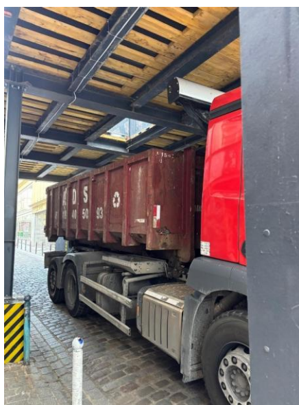
Figure 15 : Photo du camion benne en attente de l'arrivée des sacs à gravats par la trappe de la plateforme
