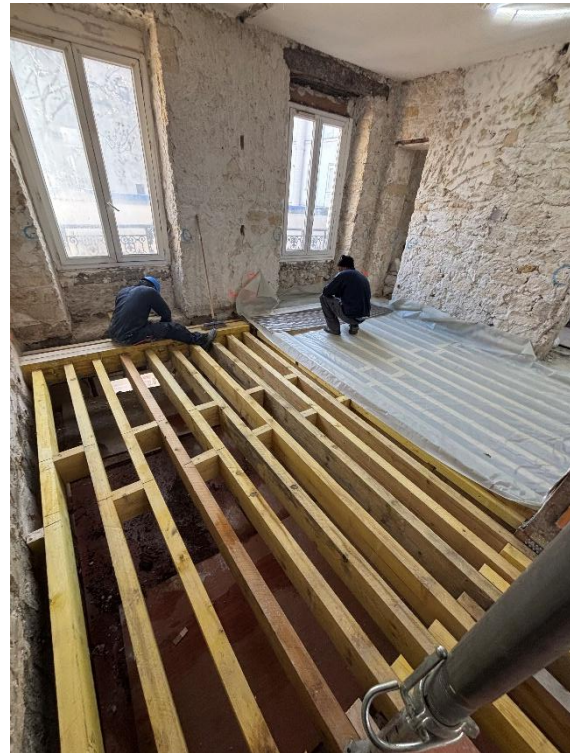
Figure 6 : étape constructive du nouveau plancher du R+1
