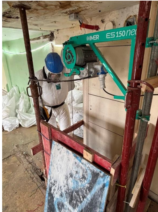
Figure 11 : Utilisation du treuil pour descendre des sacs à gravats
