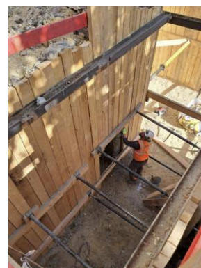
Figure 29 - Photo de la démolition de l'ovoïde inconnu (Source : INGEROP)
