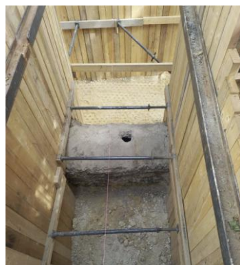
Figure 27 - Photo du sondage réalisé sur l'ovoïde inconnu (Source : INGEROP)
