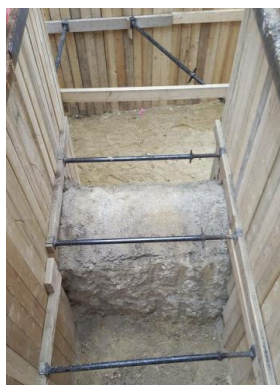
Figure 26 - Photo de l'ovoïde inconnu découvert sur le tracé de la galerie N1 (Source : INGEROP)
