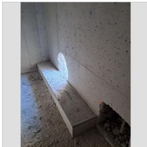
Galerie N2/N3 - Réserve réalisée pour le futur raccordement provisoire FU des RV. MCF demande à FNT de s'assurer que cette réservation est conforme et permet le fonctionnement gravitaire du réseau.
