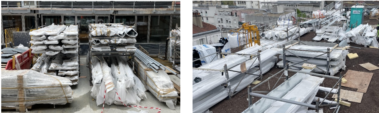
Figure 16 : Nouvelle méthode de stockage des tôles, (source : production personnelle)
