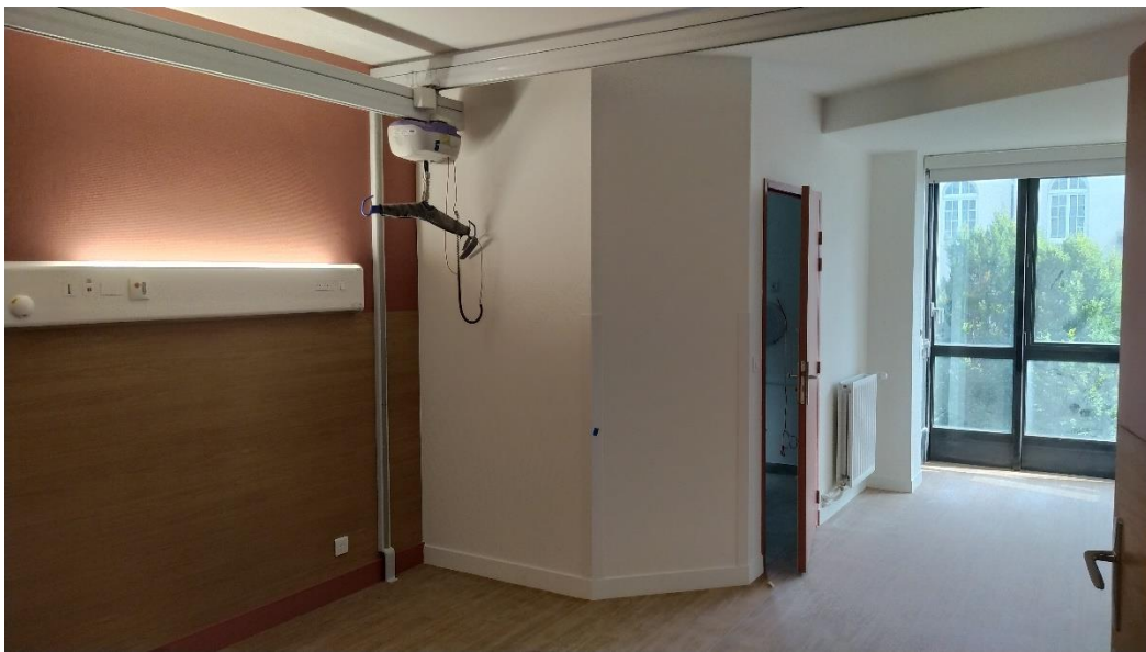
Figure 20. Photo d'une chambre double une fois les travaux terminés, pendant le nettoyage de la DASEL préalable à la mise en service (©Léo SERRA).
