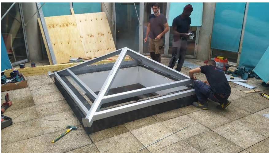
Figure 30. Le nouveau skydome est en cours d'assemblage (© Léo Serra)
