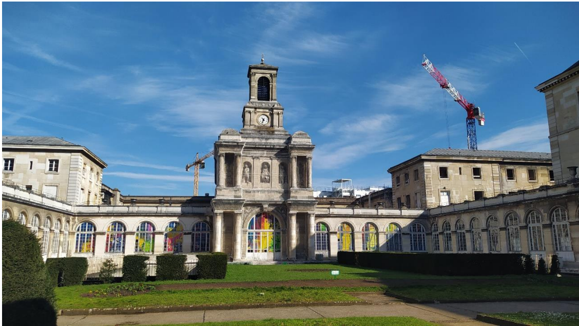
Figure 3. Photo de la chapelle de l'hôpital Lariboisière avec autour les 2 galeries reliant les peignes. Dans le fond un des grues présente sur le chantier de construction du nouveau Lariboisière. (Crédits : Léo SERRA)
