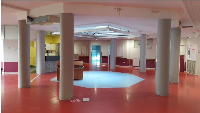
Figure 24. Photo du patio avant le début des travaux (© Léo Serra)
