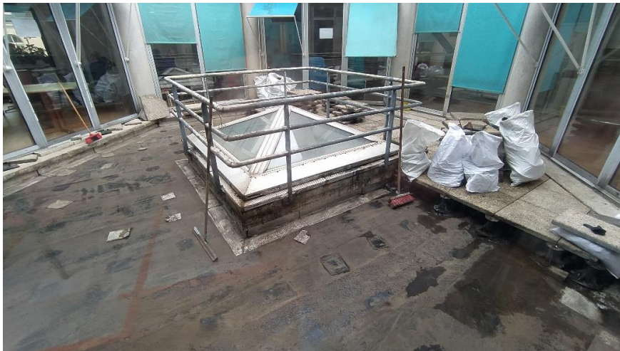
Figure 29. Reprise de l'étanchéité de la terrasse. Tout le matériel est stocké sur la terrasse afin de ne pas impacter le service autour (© Léo Serra).
