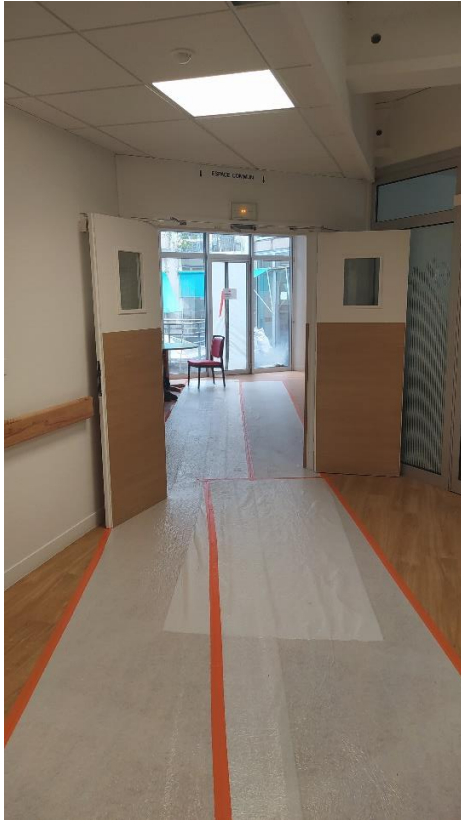
Figure 27. Photo des protections mises en place pour l'acheminement du matériel vers la terrasse où se situe le skydome à remplacer (© Léo Serra)
