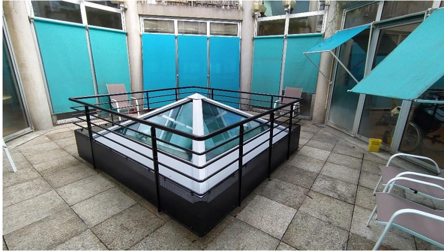
Figure 31. La terrasse une fois les travaux terminés (@ Léo Serra)
