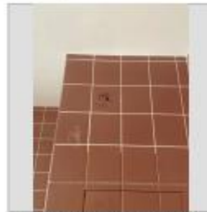
FLIPO dépose les carreaux de faïence. SPIE trace la réservation DECOR réalise l'ouverture. SPIE pose la VMC.
