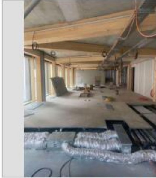
Travaux SPIE à solder avant fermeture totale du FP 27 mai 2024 10:35
