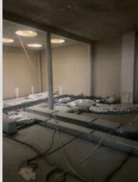
Pose du FP non débuté dans l'extension. 30 avril 2024 17:02
