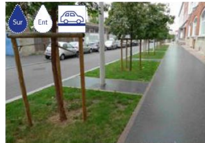
LA COURNEUVE : TRANCHÉE VÉGÉTALISÉE ENTRE LES ARBRES D'ALIGNEMENT. Source : © APUR
