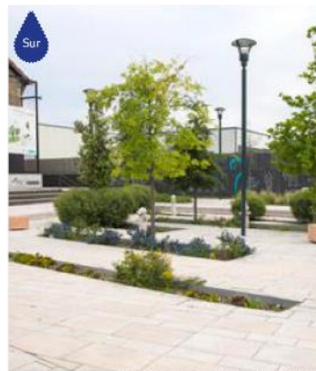
ROMAINVILLE : ESPACE VÉGÉTALISÉ INFILTRANT EN DÉCAISSE DE L'ESPACE PUBLIC Source : Est Ensemble / Gaël Kerbaol
