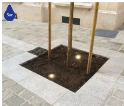
FOSSE D'ARBRE DÉCAISSÉE - NEUILLY (92). Source : ATM
