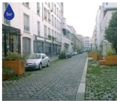
RUE DE CITEAUX : JARDINIÈRES HORS SOL SUR L'ESPACE PUBLIC ET PAVÉS VÉGÉTALISÉS. Source : SEPIA Conseils
