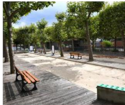
REVÊTEMENT PERMÉABLE EN SABLE ET BOIS. Source : QUATREVINGDOUZE / AESN
