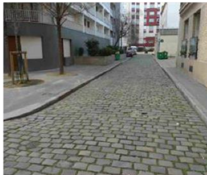
PASSAGE MONTBRUN : PAVÉS À JOINTS ENGAGONNÉS. Source : © APUR
