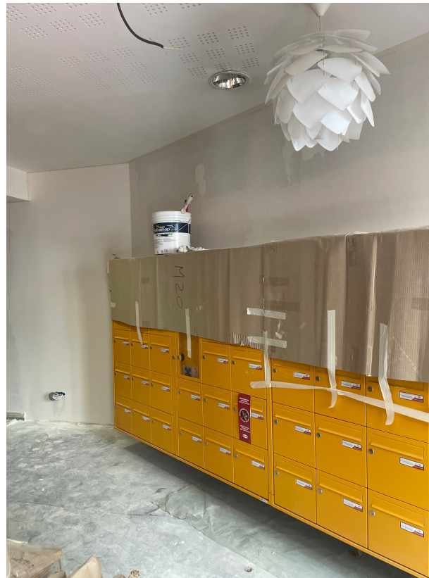
Mise en place des boîtes aux lettres pour les logements dans le hall
