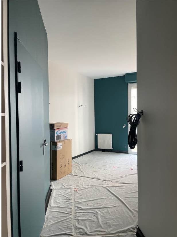
Logement du RDC
