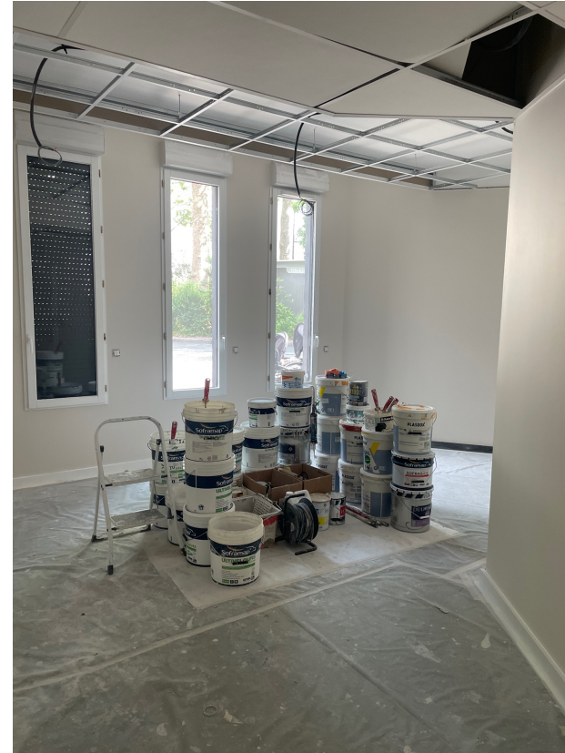
Premier bureau du RDC
