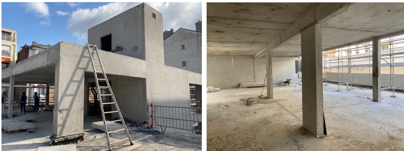
Figure 9 : Travaux de curage et de désamiantage pour le projet de réhabilitation à destination de co-living – Boulogne-Billancourt
