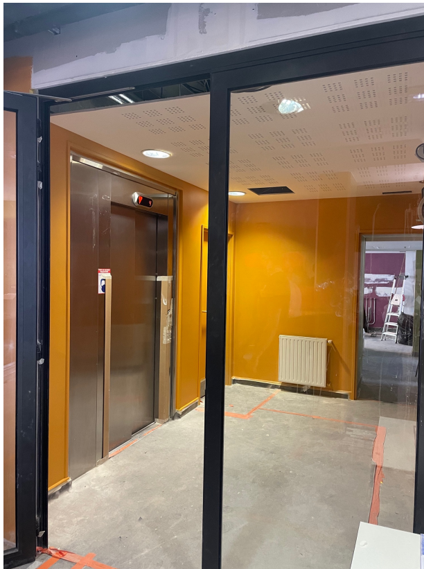
Mise en place de la porte vitrée pour le contrôle d'accès de la résidence
