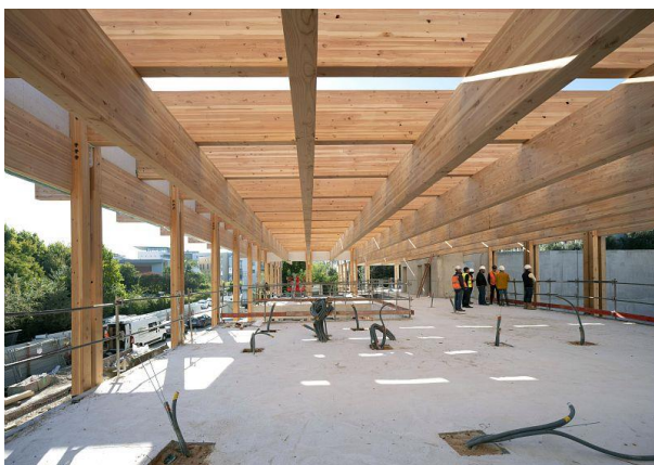
Figure 6 : Chantier de construction du bâtiment d'exploitation. Sylvain Duffard
