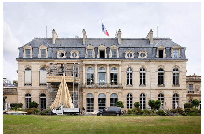
Figure 1 : Chantier de l'Hôtel d'Evreux. Alexis Paoli
