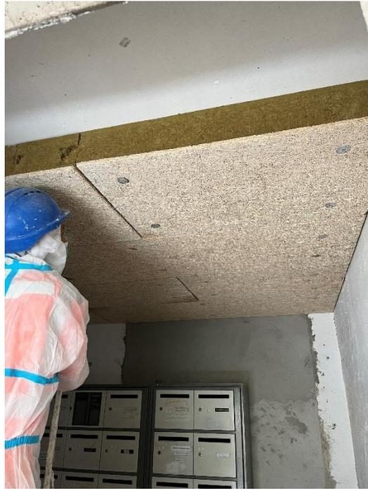
Figure 20 - Suivi de mise en œuvre d'isolant aux locaux au RDC. Source : auteur (2023)
