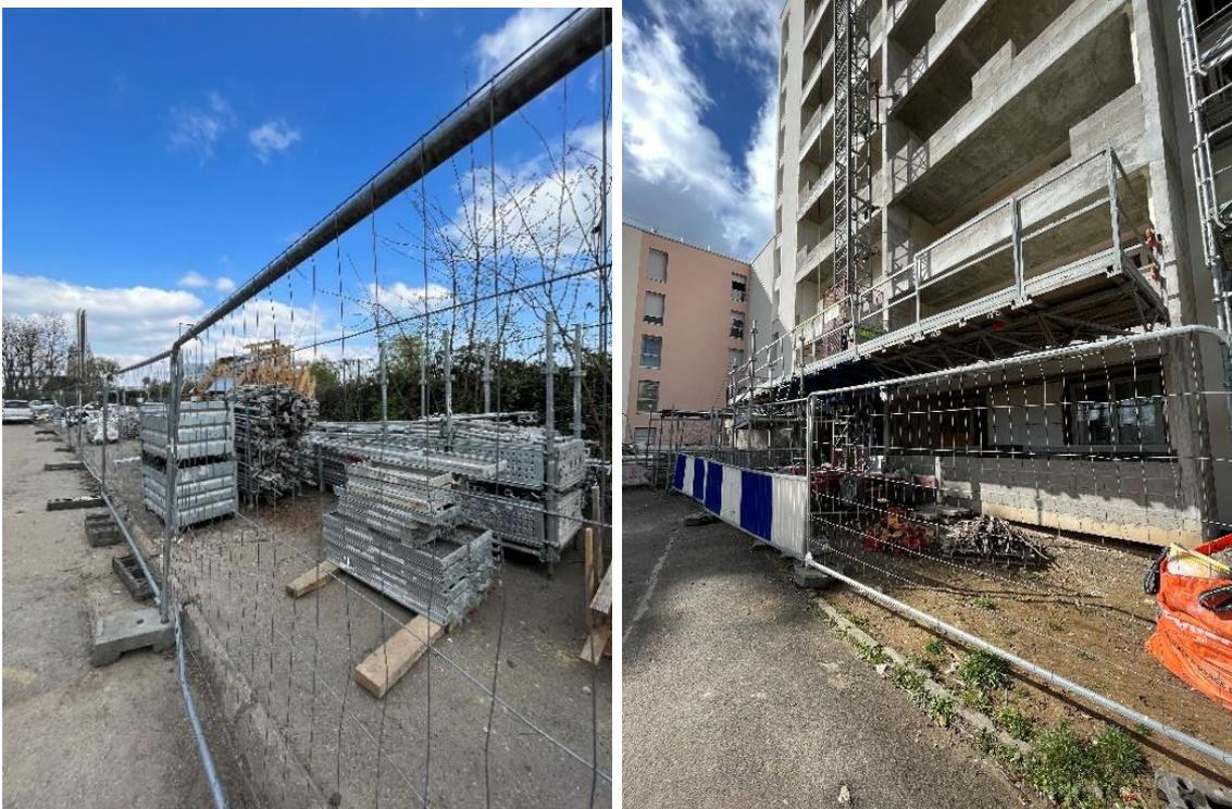
Figure 32 : Création de zones fermées et propres de stockage des matériels et de travaux. Source : auteur (2023)
