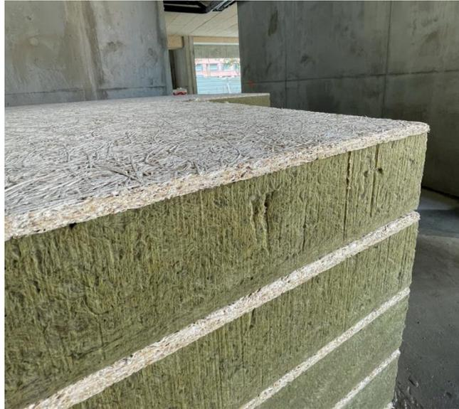
Figure 18 - Isolant pour le plafond des locaux : Rockfeu Wood A2 RsD. Source : Rockwool (2023)
