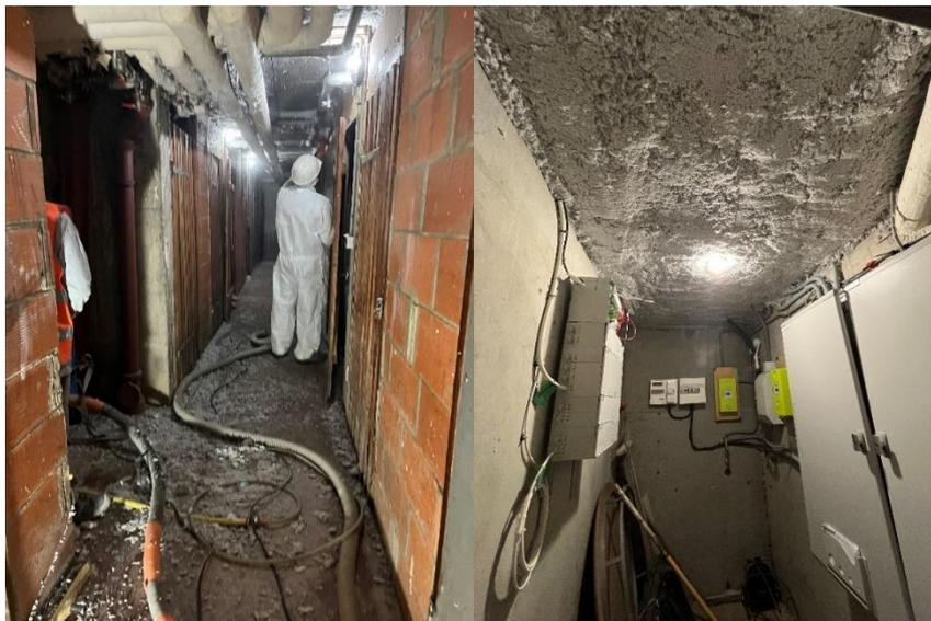
Figure 15 - Suivi des travaux de flochage au sous-sol. Source : auteur (2023)
