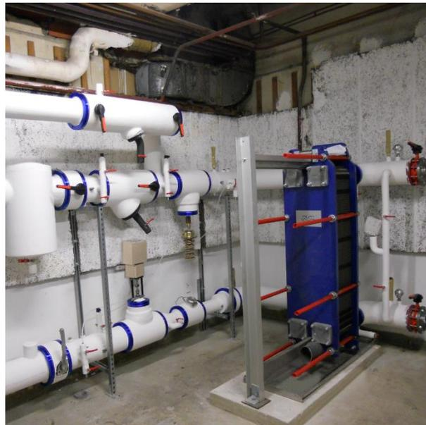
Figure 3. Poste de livraison d'un client abonné CLIMESPACE
