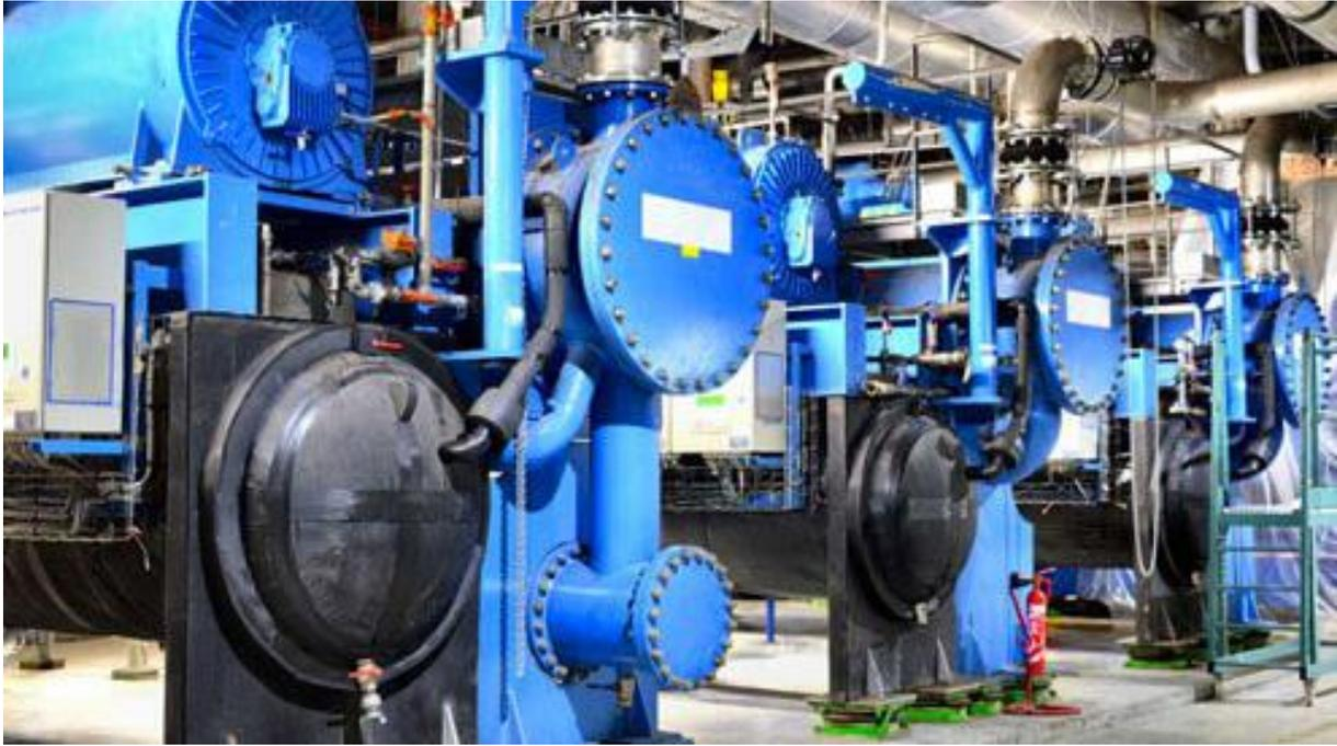
*Figure 8. Quelques machines frigorifiques, appelées "Groupes Froid" (environ 5 mètres de hauteur)*
