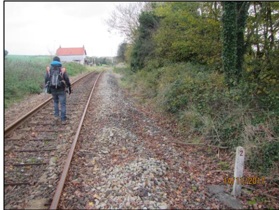
Figure 16. Vue du tronçon Pk 127+140 - Pk 127+200 depuis le Pk 127+200
