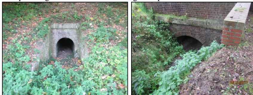
Figure 9. Photographies de deux ouvrages hydrauliques de traversée sous voie - Source interne
