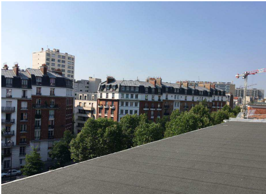
Figure 12 : Toiture du collège Modigliani (Paris 15ème) - Source : Réalisation personnelle
