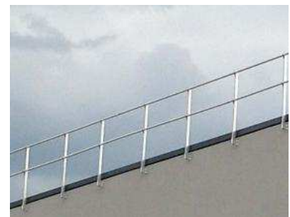
Figure 13 : Garde-corps avec ancrage externe
