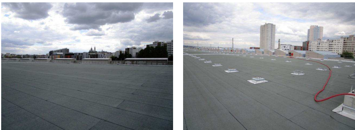
Figure 15 : Le site Chapelle International dans le 18ème arrdt. – Source : parisculteurs.paris
