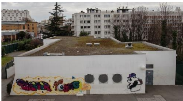
Figure 9 : photo de la toiture Pailleron qui abritera le projet Veni Verdi
