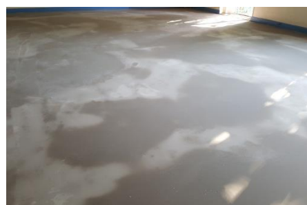
Figure 11 : photo du ragréage d'un sol de salle de classe – crédit personnel
