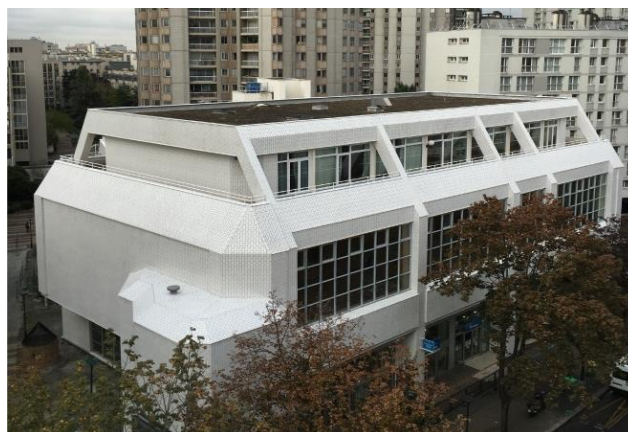
Figure 10 : photo de la toiture Mathis qui abritera le projet Plant Social
