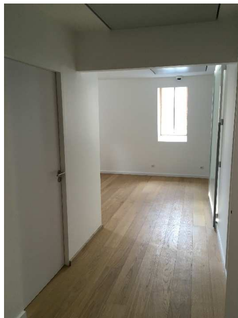
Figure 7 : Pose du parquet dans la zone témoin
