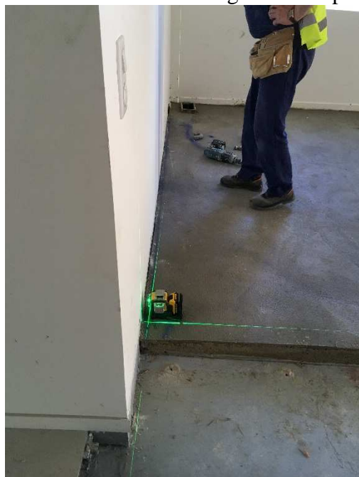
Figure 6 : Réalisation d'un tracé de cloison
