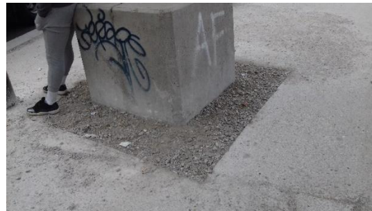
76 : Pied de mât à bétonner
