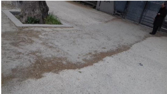
67 : Reprendre la planéité du béton
