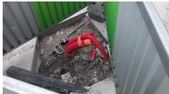
78 : Pied de mât à bétonner après mâtage
