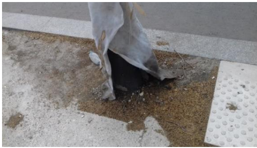
65 : Pied de mât à bétonner
