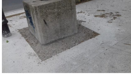
66 : Pied de mât à bétonner
