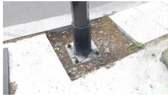
72 : Pied de mât à bétonner
