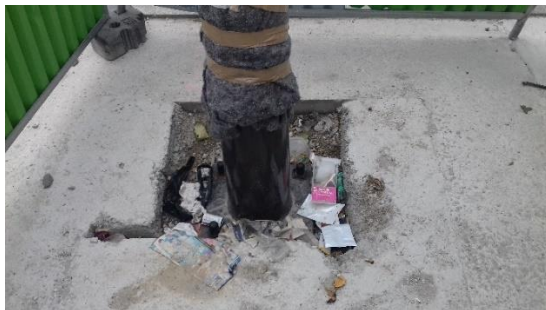
75 : Pied de mât à bétonner
