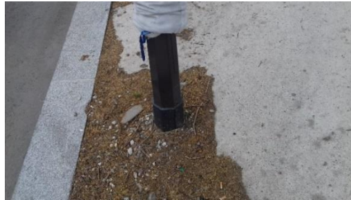
66 : Pied de mât à bétonner
