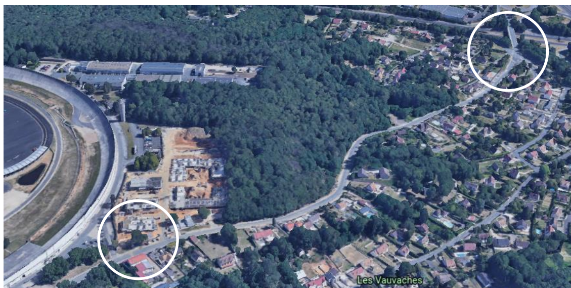
Illustration 6 : vue aérienne de l'avenue Georges Boillot, Linas (© Google Earth)
