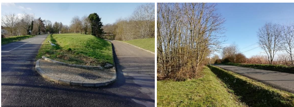
Illustration 15 (à gauche) : vue du dénivelé au niveau de l'intersection de l'axe principal avec la RD224 (© IRIS Conseil)
