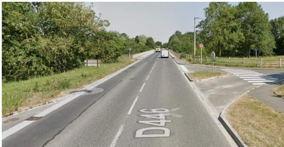
Illustration 27 : vue de l'intersection entre la RD 446 et le chemin menant au cimetière depuis la RD 446 (© Google Maps)
