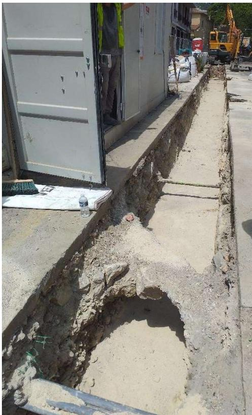
Figure 20 : Réalisation de la fouille avec lit de pose en sable pour pose des canalisations
