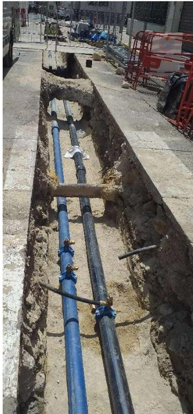
Figure 19: Pose de canalisation sur Sorgentino, AEP (gauche) et EB (droite).
