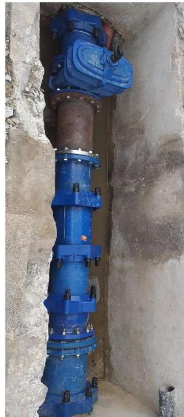
Figure 21: Montage réalisé dans la chambre Demontzey en attendant le débitmètre.
