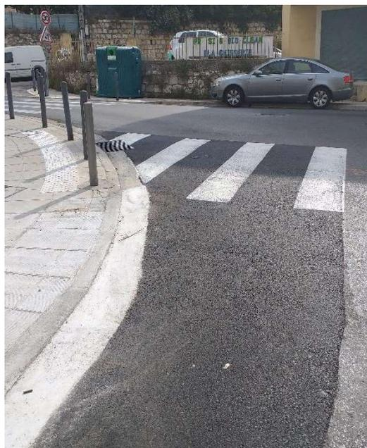
Figure 23: Réfection finale en enrobés chauds sur l'avenue Giacobi.
