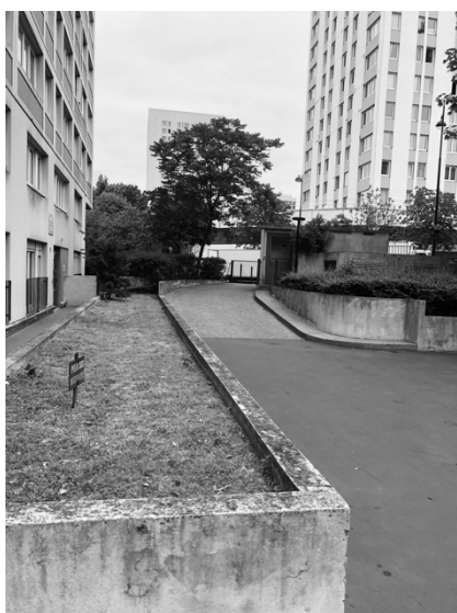
Figure 14 : Photo des espaces verts avant travaux. Prise par l'auteur
