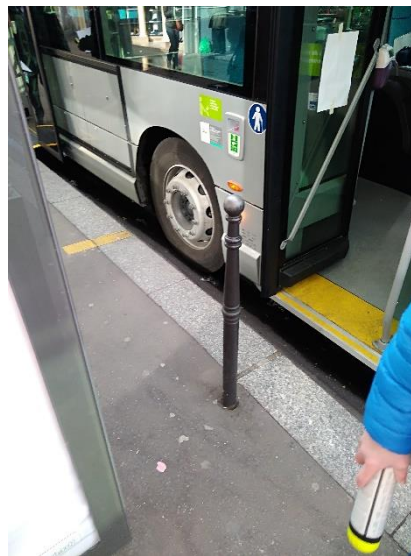
Photo 4 - Potelet encombrant à l'arrêt place de Clichy Caulaincourt
