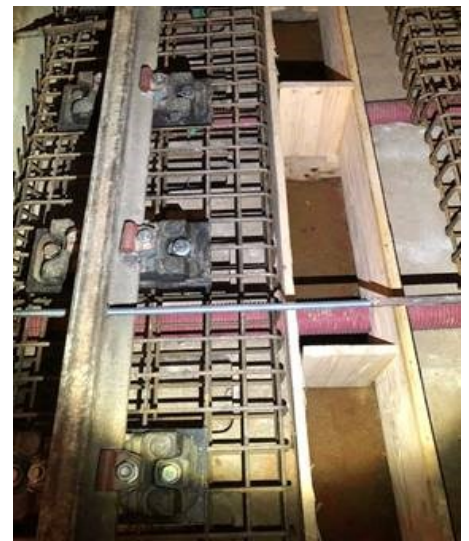
Figure 23: Problématique caniveau et respect de l'enrobage (©ROUGUI Ghizlane & El MELOUANI Kamal)
