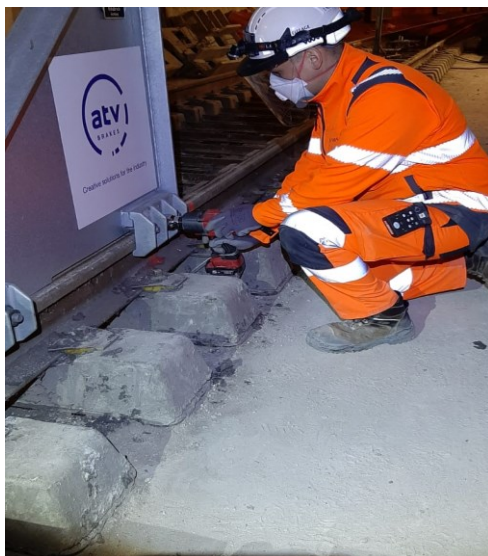
Figure 22: Pose du heurtoir (©BOUABDELLAH Ishak, Conducteur Travaux Magenta , Rapport Journalier)
