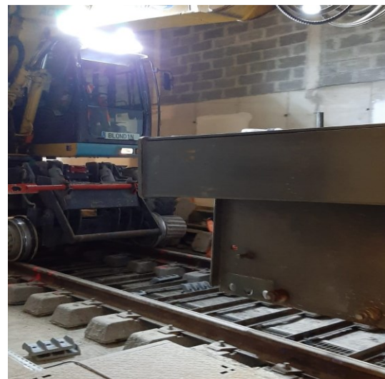
Figure 22: Pose du heurtoir (©BOUABDELLAH Ishak, Conducteur Travaux Magenta , Rapport Journalier)
