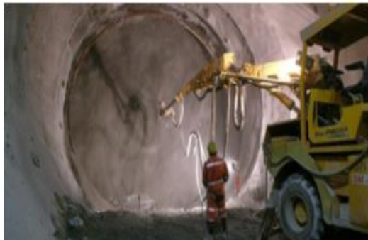
Figure 9: Application du béton projeté sur la partie excavée du tunnel
