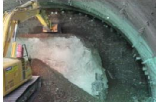
Figure 18 : Composition du sol observée pendant la construction de l'accès à la station
