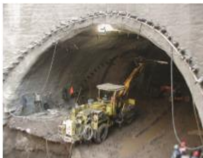
Figure 23 : Excavation de l'accès à la station
