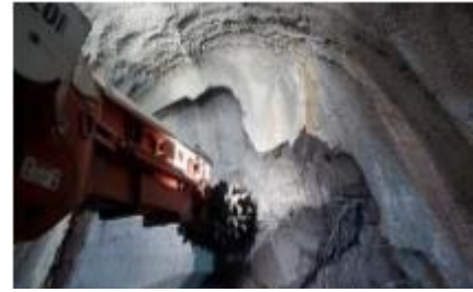
Figure 7: Machine à attaque ponctuelle pour creuser le tunnel
