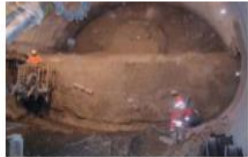
Figure 8: Excavation du tunnel en deux parties avec le modèle du Top heading/bench
