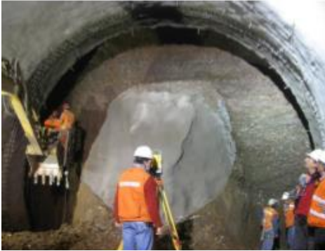
Figure 17 : Composition du sol observée pendant la construction du tunnel
