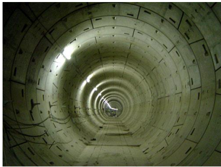
Figure 26 : Intérieur du tunnel
