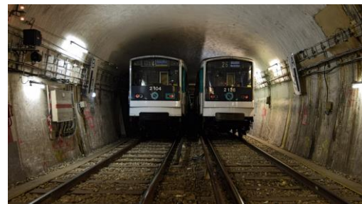
Figure 20 : Tunnel double voies
