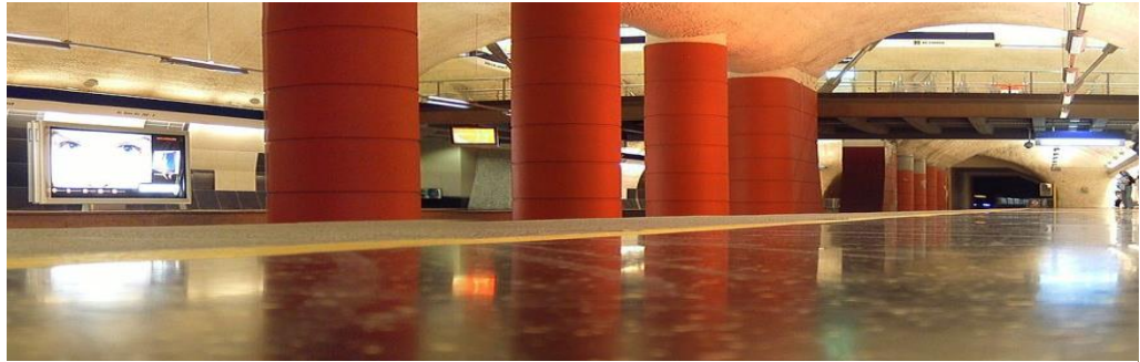
Figure 25 : Intérieur de la station Plaza Egana construite avec la méthode binoculaire
