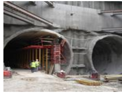
Figure 27 : Deux tunnels à voie unique
