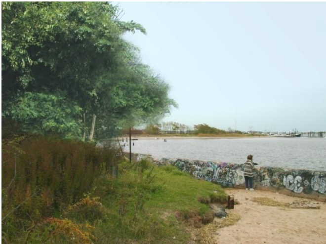
Figure 69 : Etat actuel du mur en déclin
