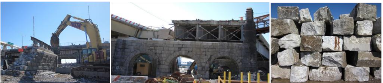
Figure 33 : Destruction du Pont de Willis Avenue et pierres de granite récupérées
