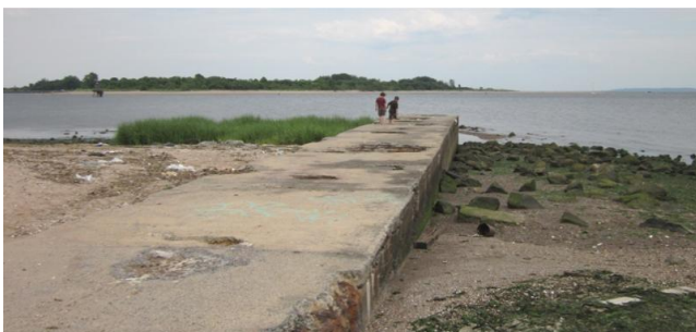
Figure 10 : Canalisation de rejet des eaux pluviales
