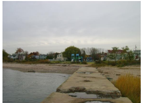
Figure 27 : Etat actuel du rejet des eaux pluviales
