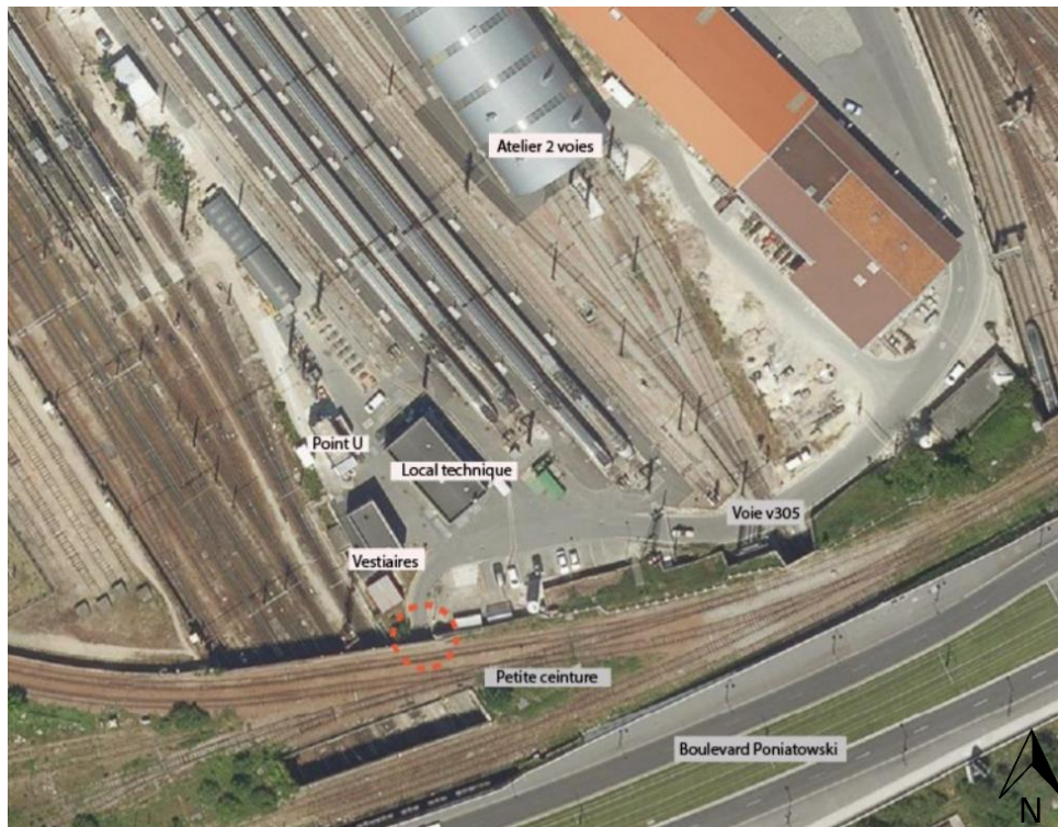
Figure 1 : Vue aérienne du Technicentre Sud-Est Européen (TSEE) Paris-Conflans
