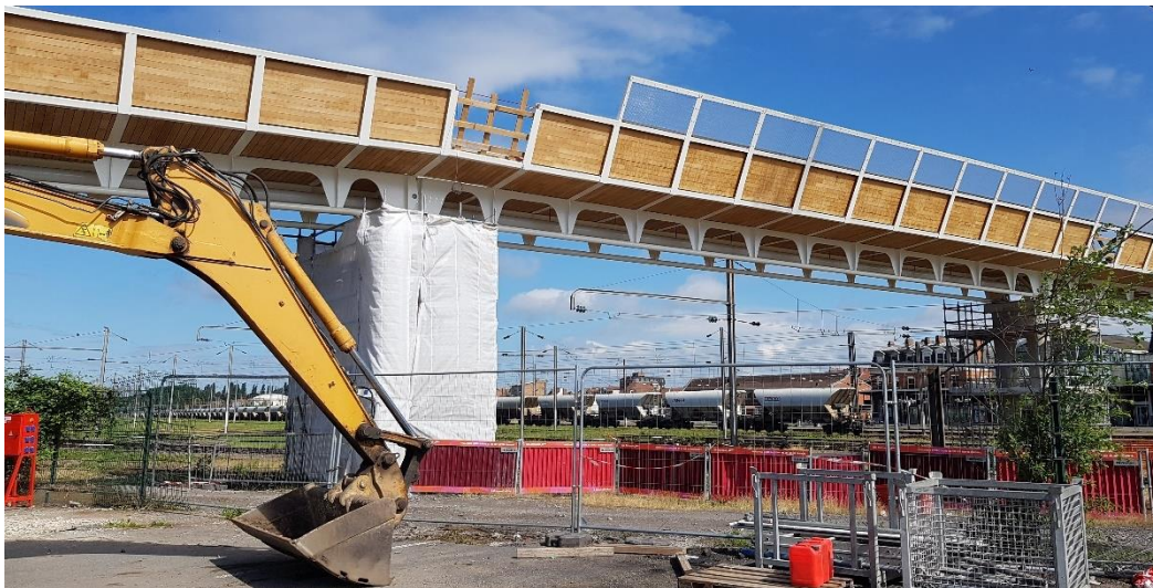
Figure 7 : Protection des piles (©Mathilde Soulé)
