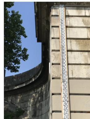
Figure 2: échelle hydrométrique du pont d'Austerlitz
