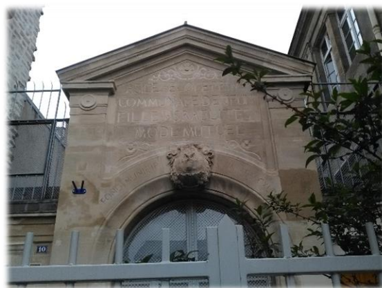
FIGURE 16 : FRONTON DE L'ECOLE HOSPITALIERE ST GERVAIS APRES LES TRAVAUX
