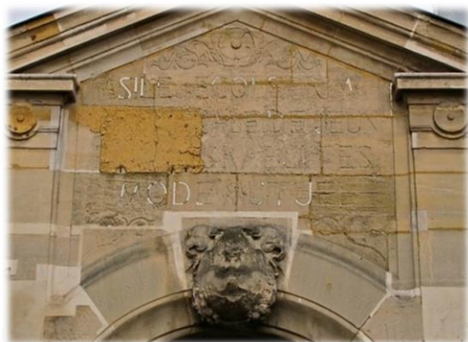
FIGURE 15 : FRONTON DE L'ECOLE HOSPITALIERE ST GERVAIS AVANT LES TRAVAUX
