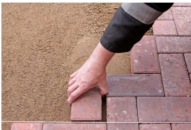
*Exemple de pavés autobloquants à joints sable*
