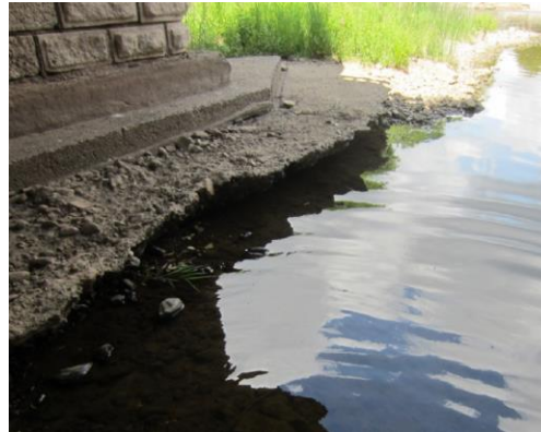
Figure 7 : Photographie d'une semelle du pont Denfert Rochereau – Photo Egis
