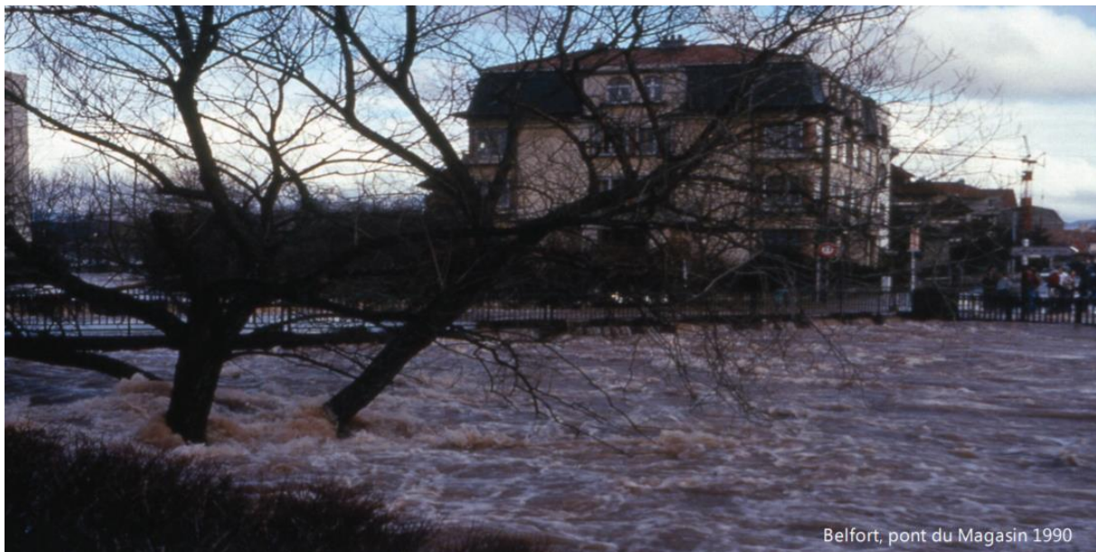
Figure 3 : Pont du magasin lors de la crue de 1990 (source : ICC territoire de Belfort)
