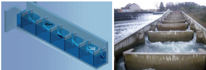
Figure 2 : Schéma d'une passe à poisson à fente verticale et photo (Photo : Voegtlié – Ecogea).
