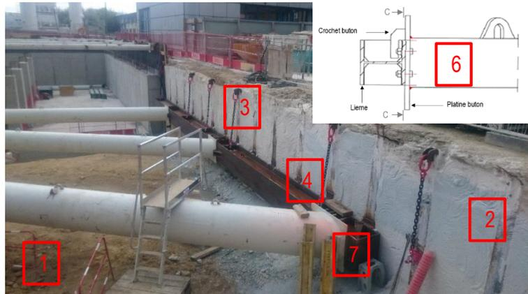
Figure 20. Mise en place de butons niveau +29.10 NGF
