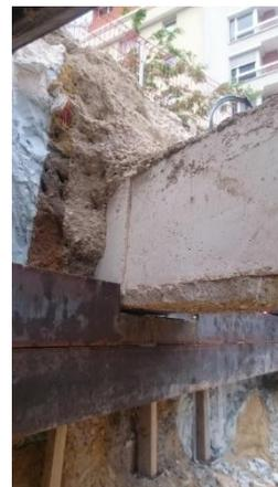
Figure 24. Conflits entre le réseau existant et les liernes. Lierne partiellement découpée afin d'être posée à la cote indiquée sur le plan.
