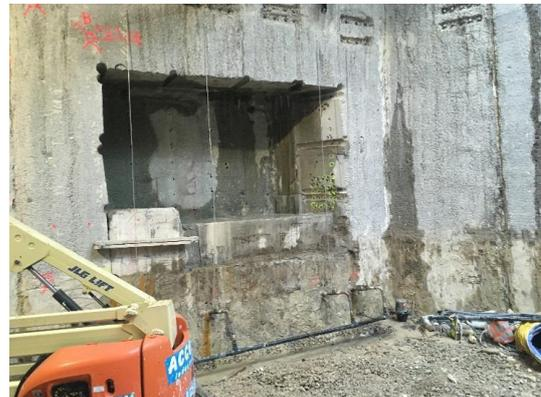
Figure 12. Réalisation des drains suite à la venue d'eau dans la BAM
