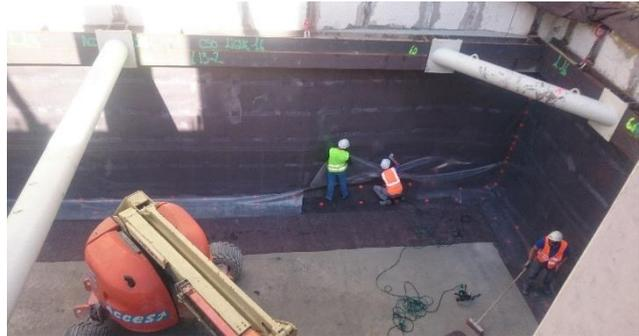
Figure 28. Réalisation de l'étanchéité
