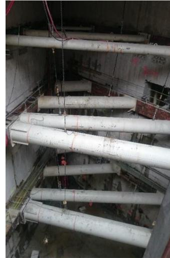
Figure 11. Mise en place des butons dans la BAM
