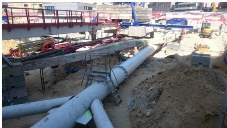
Figure 23. Mise en place du buton B11 en dessous des passerelles de supportage des réseaux
