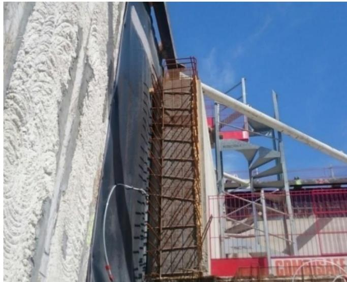
Figure 35. Arrêt de bétonnage stremaform
