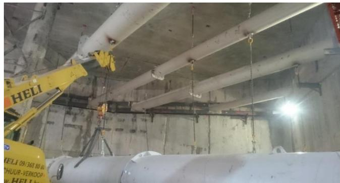
Figure 18. Mise en place de butons CSO avec le système de suspenste
