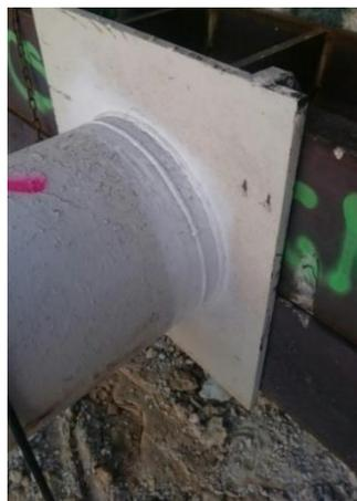
Figure 25. Erreurs de fabrication des butons. Buton découpé et résoudé sur la platine
