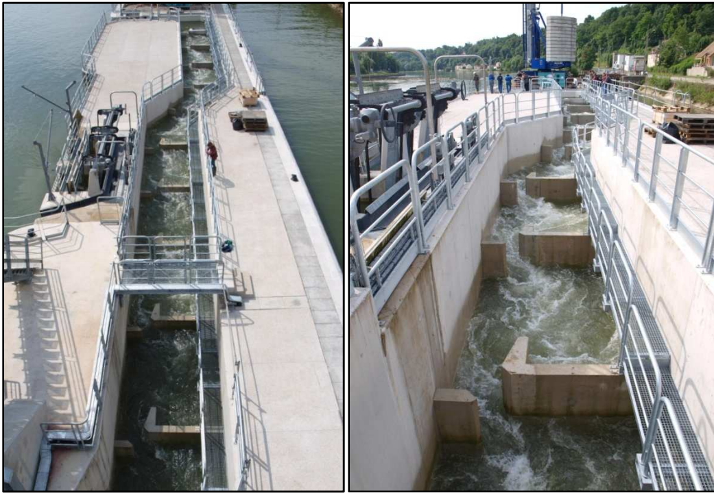
Figure 8: la passe à bassins successifs du Coudray-Montceaux. Crédit: DTBS.
